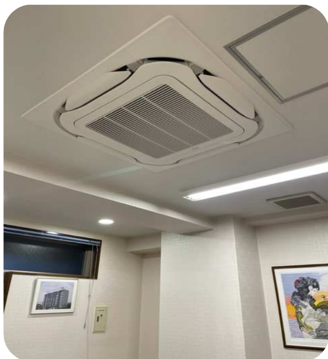
会議室空調機入替 (室内機1台・室外機1台) 2021年7月14日実施
