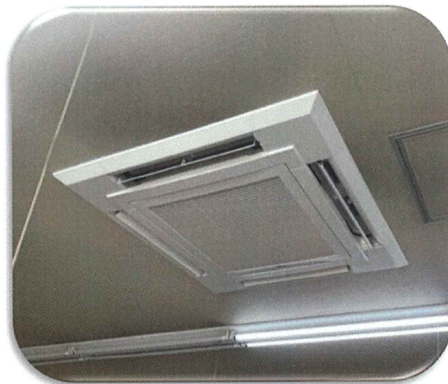
事務所1階西側空調機入替 替 (室内機1台・室外機1台)
